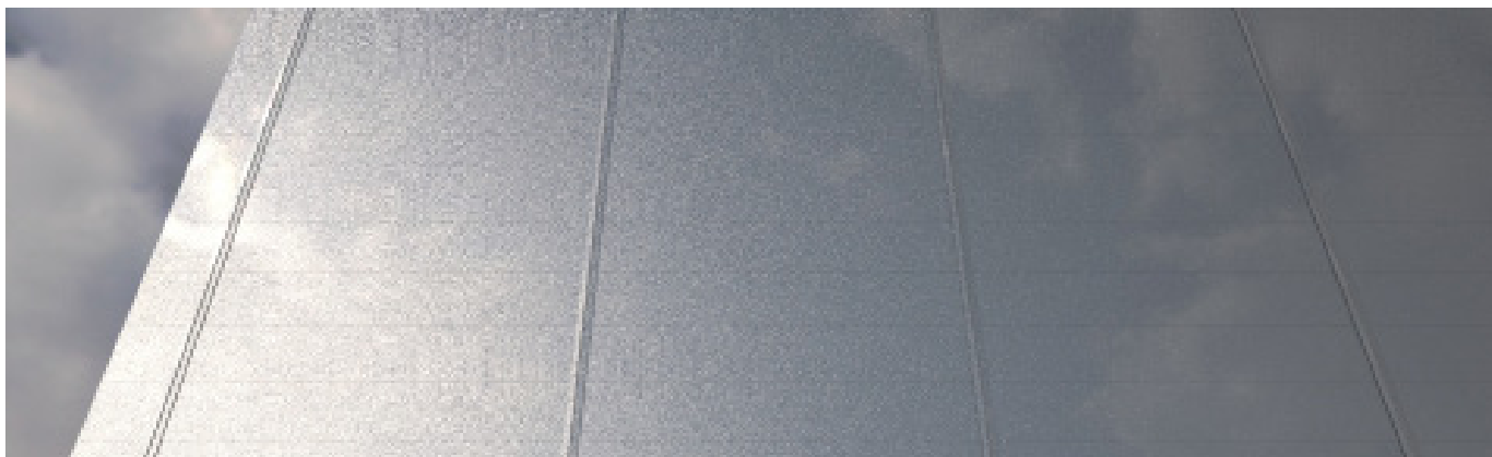
Fasad med pilaster 9
