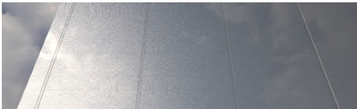
Fasad med pilaster 10
