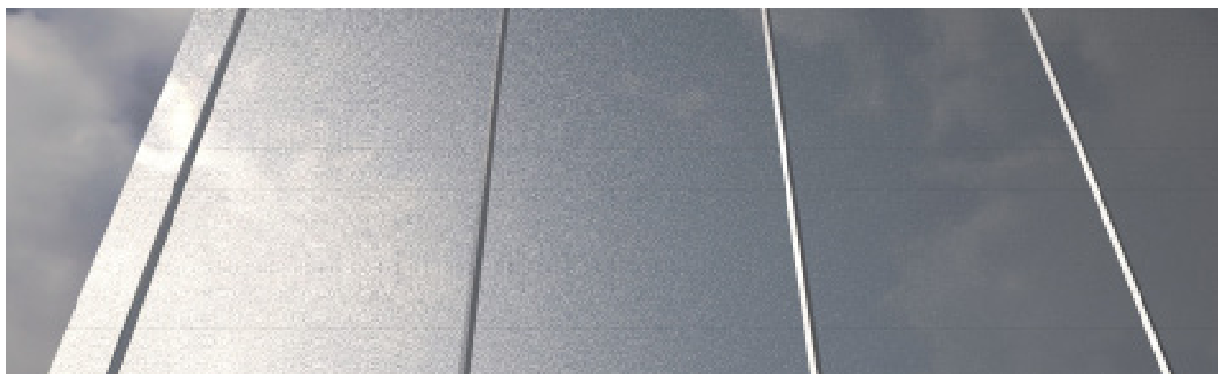
Fasad med pilaster 8
