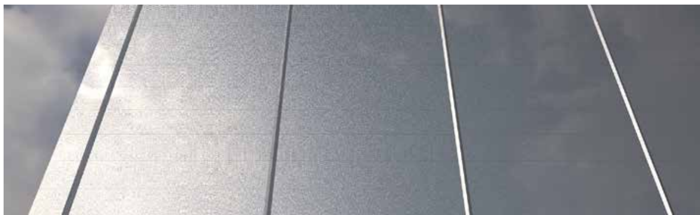
Fasad med pilaster 8
