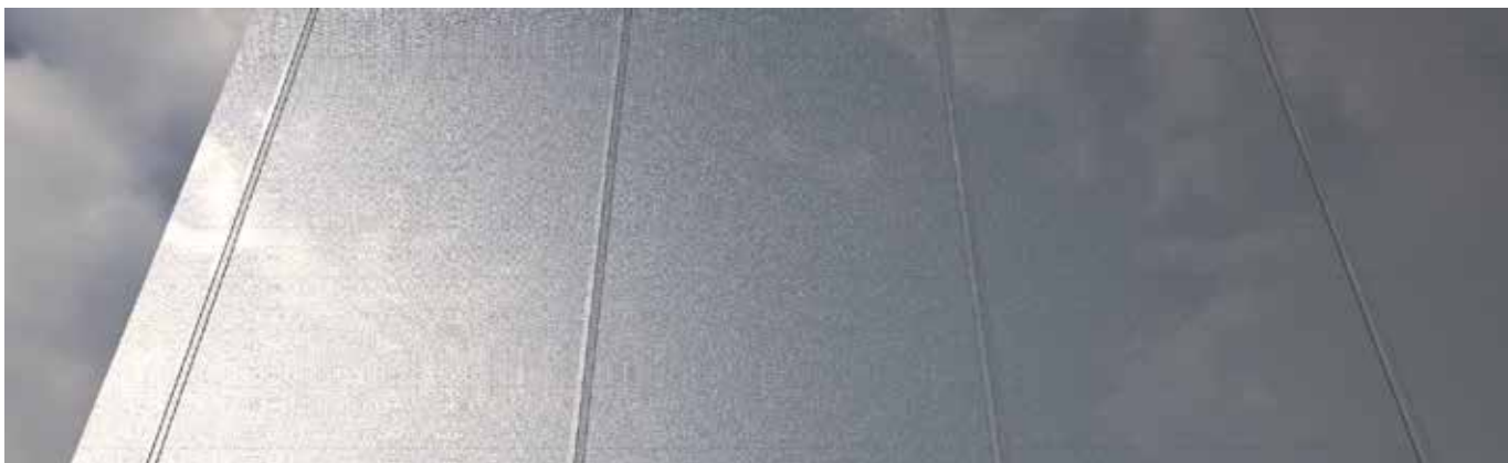
Fasad med pilaster 9
