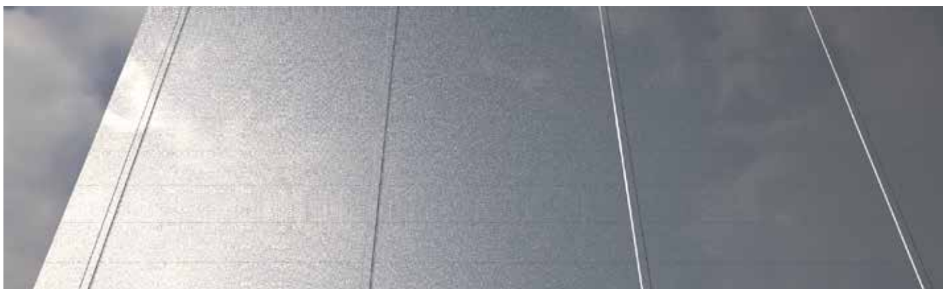
Fasad med pilaster 1
