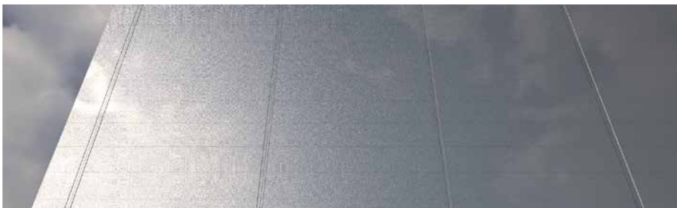
Fasad med pilaster 10
