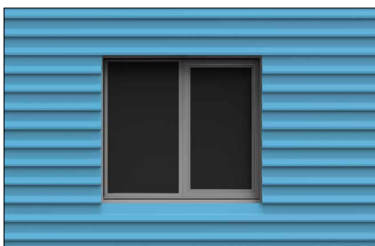
Montera resten av plåtarna runt öppningen.
