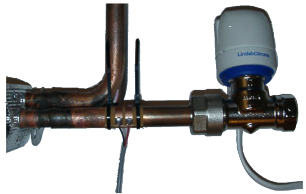
Figur 4 -Sensor fäst med 2 strips runt horisontellt kopparör.
