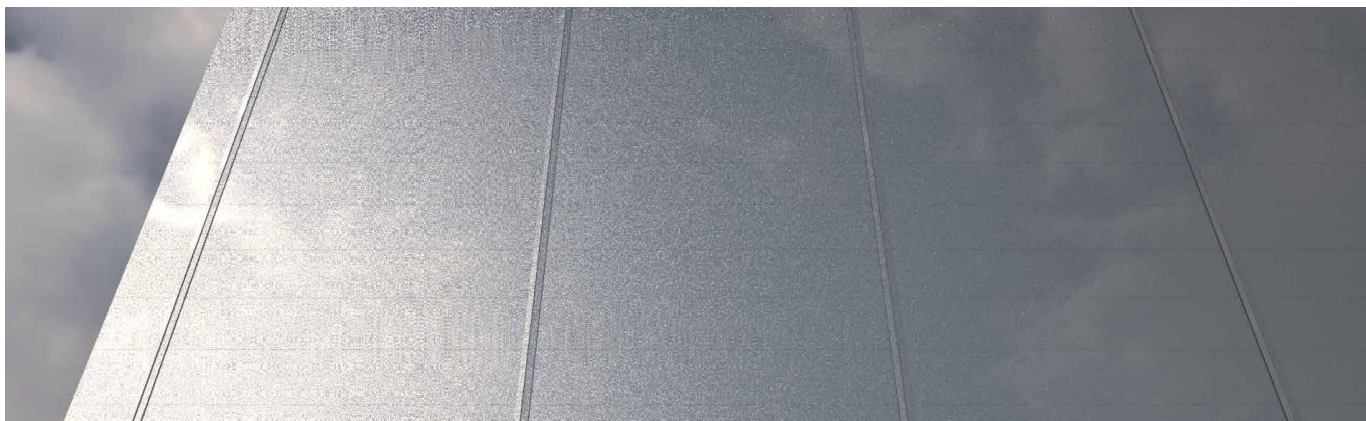
Fasad med pilaster 9
