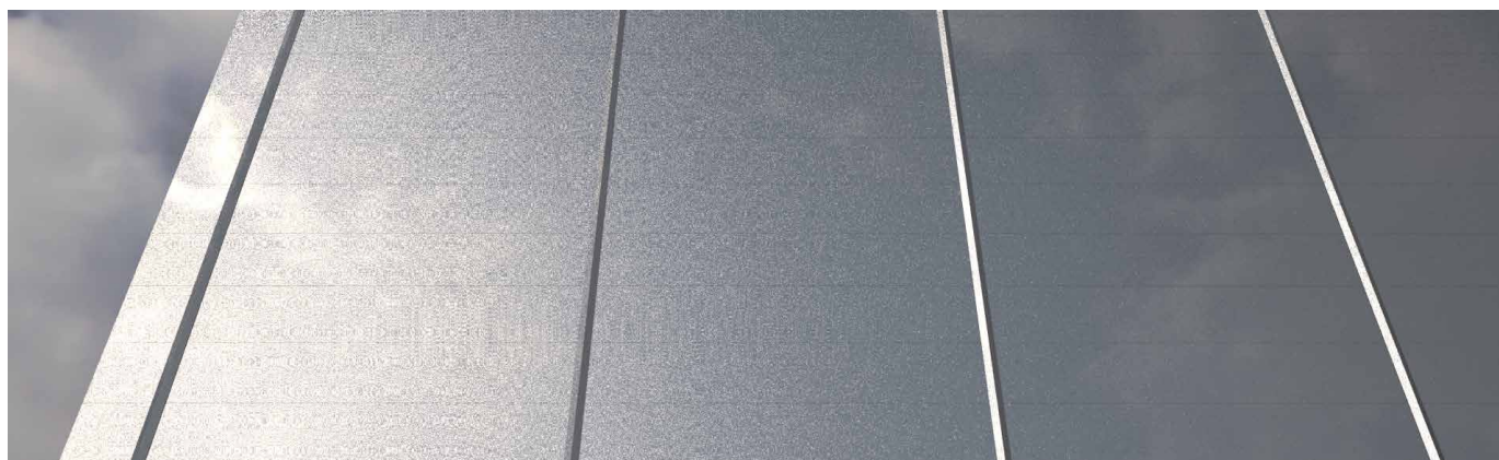
Fasad med pilaster 8
