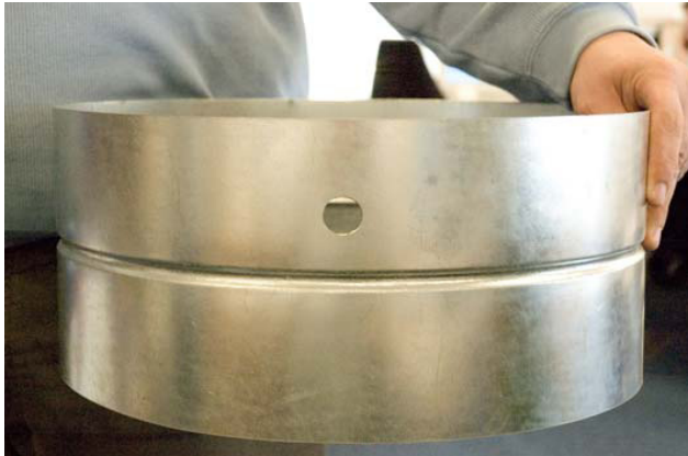
20 mm hål borras i kanal där el anslutning önskas.
