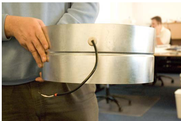
Kabelgenomföring monteras i kanal.
