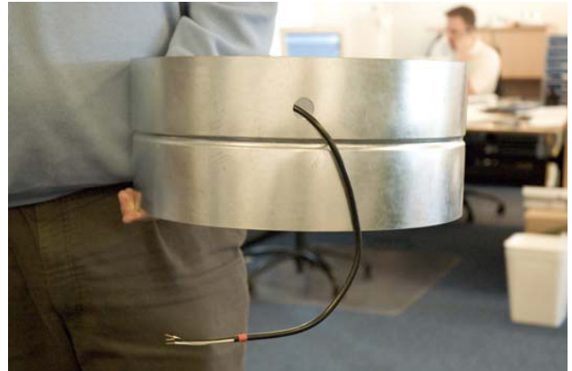
Elkabeln dras genom upp borrat hål.
