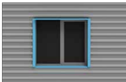
Montera beslag och fönster.
