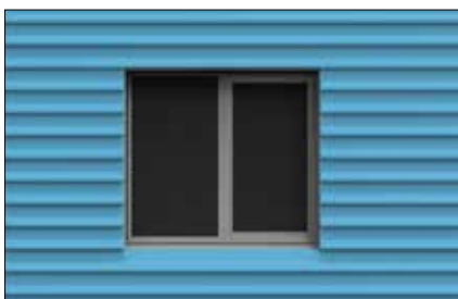
Montera resten av plåtarna runt öppningen.
