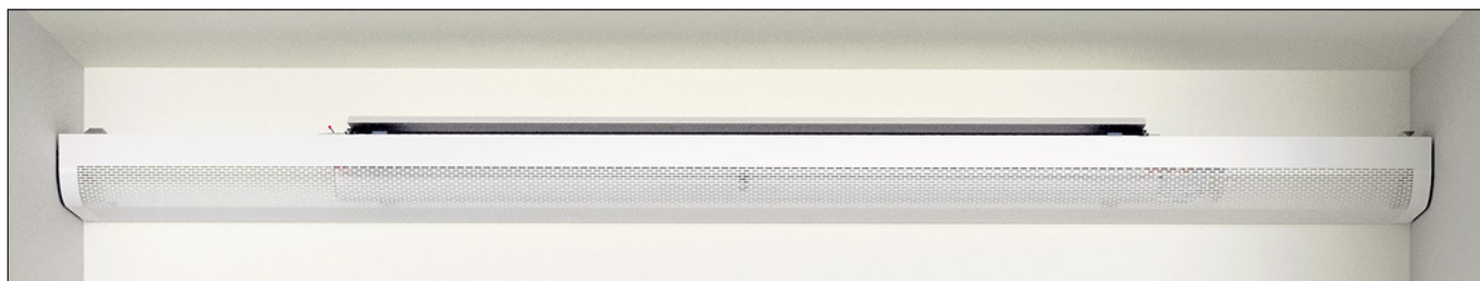
Bild 14. Plafond XD monterad på vägg med distans till tak (FW).
